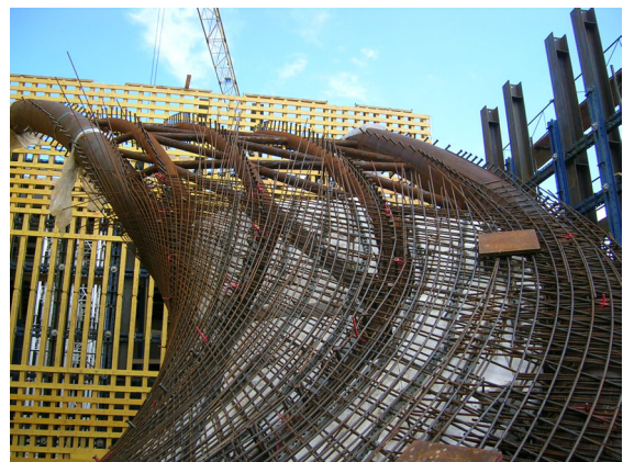
Fig. 3: Stahlhohlprofile mit Bewehrung und Füllkörper
